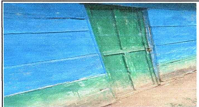
Foto 3: Se cambiarán puertas.
