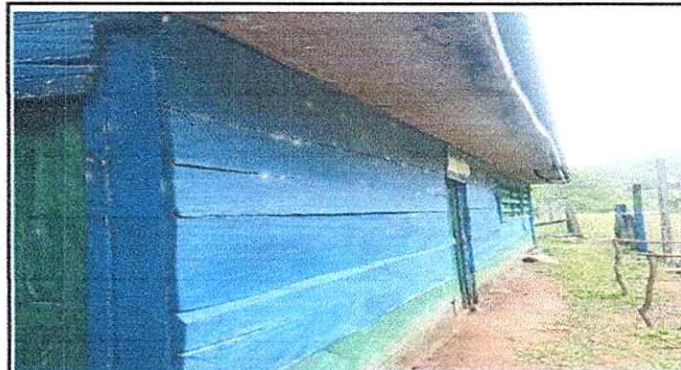
Foto 4: se cambiarán Columnas.
