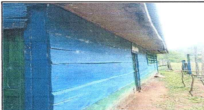
Foto 2: Se reparara paredes de las aulas.
